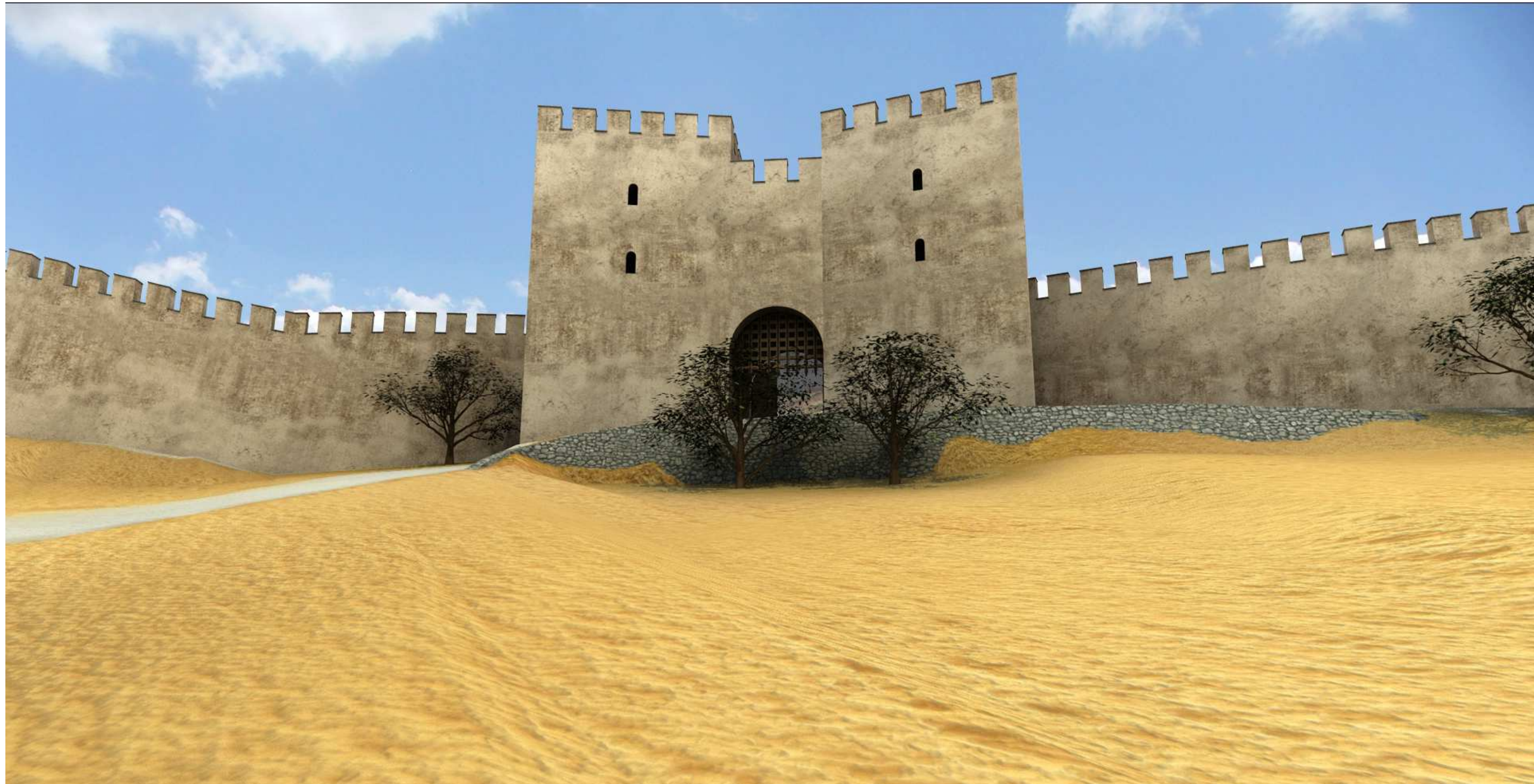
Ricostruzione della Porta Est, vista dall'esterno.
